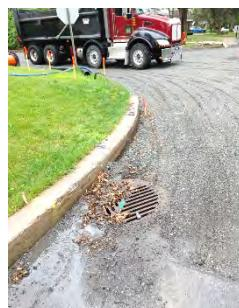
*Puisard à la limite d'un chantier captant de l'eau boueuse, du gravier et des feuilles*
