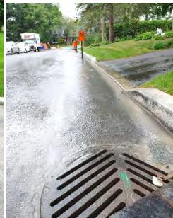
*Captage de l'eau boueuse d'un chantier par un puisard*
